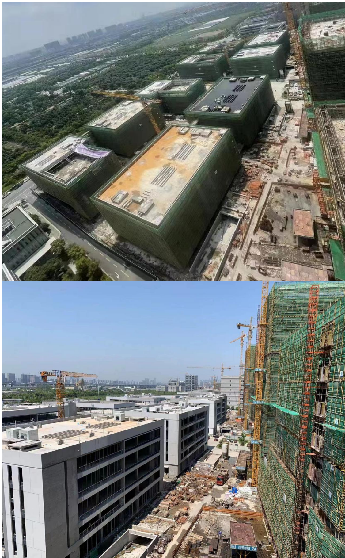
图 3.4-1 生命科学产业园一期建设现状
