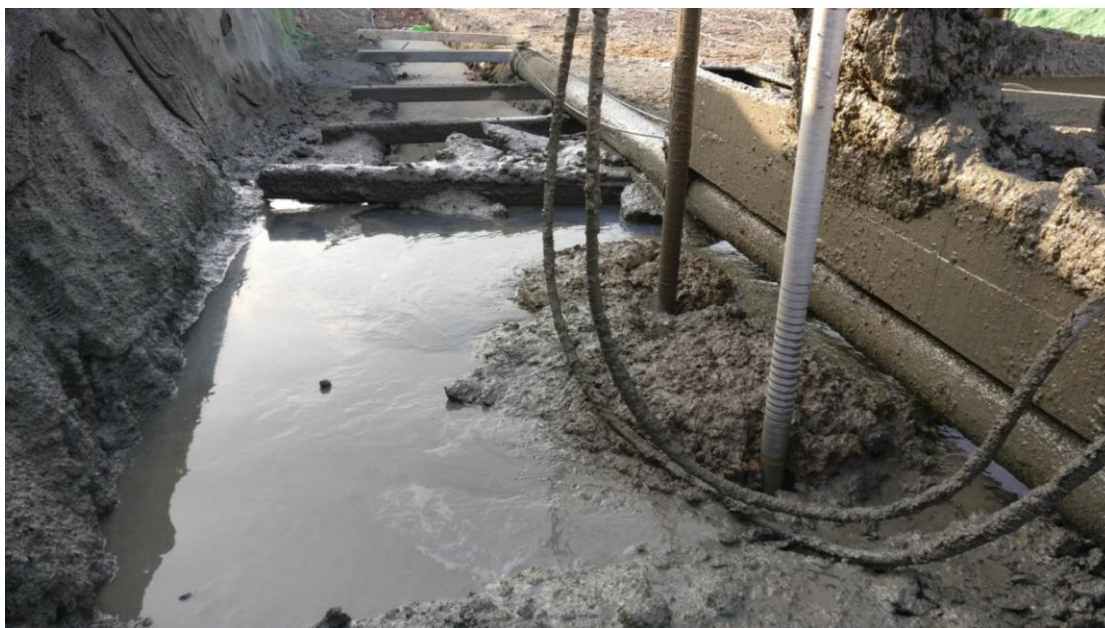
图 2.1-13 钻机下喷射管
