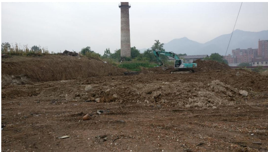
图 2.1-4 高压旋喷区域场地平整
