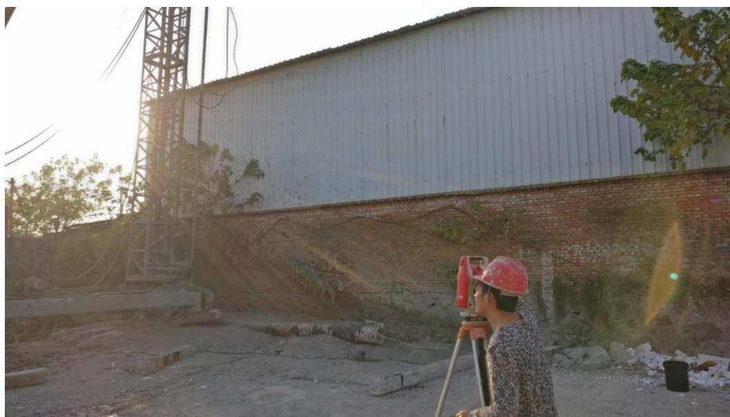
图 2.1-11 钻杆垂直度检查
