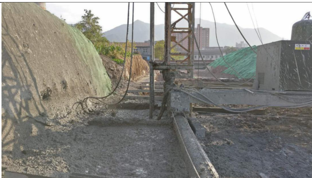
图 2.1-16 高压旋喷施工喷射提升
