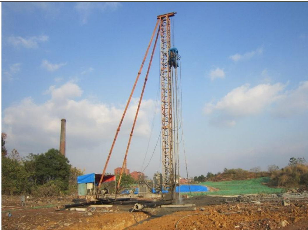
图 2.2-3 高压旋喷桩
