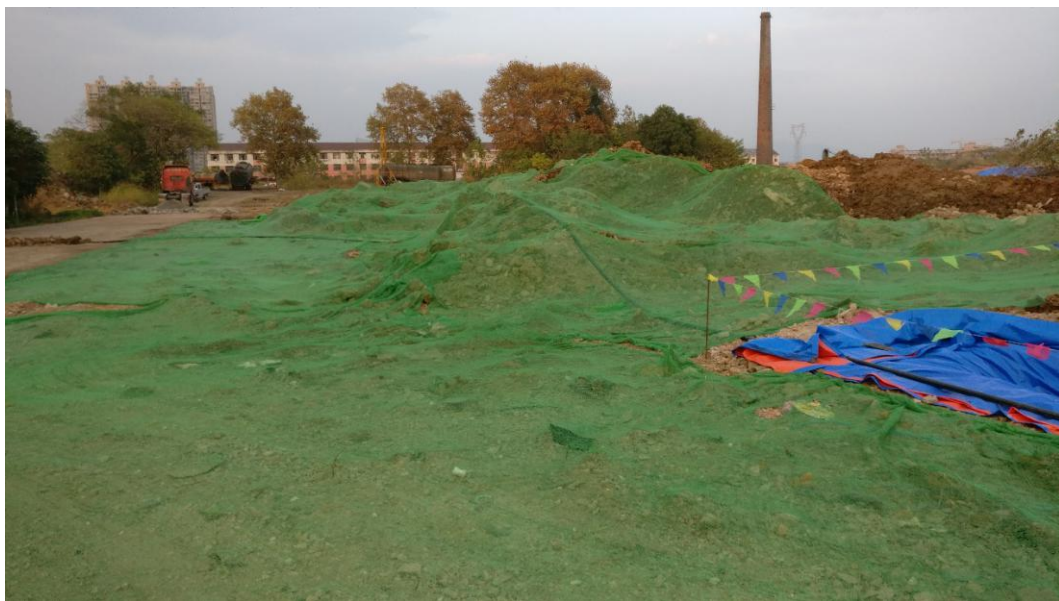
图 2.1-5 推土与建筑垃圾防尘网覆盖
