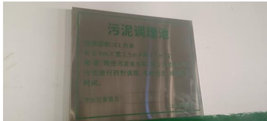
污泥调理池标识牌
