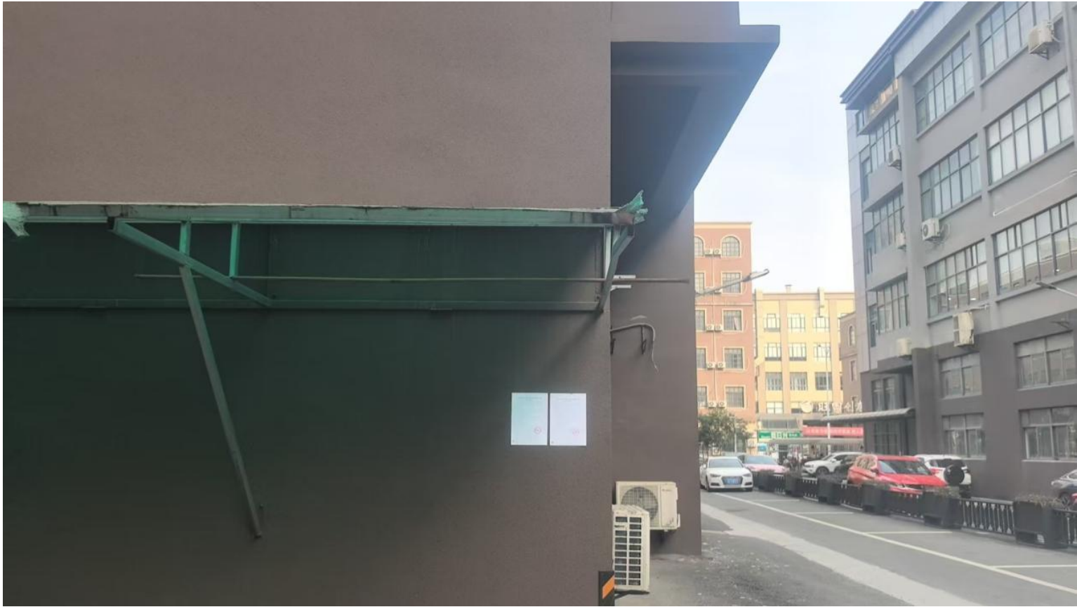
附件 6：竣工、调试公示照片
