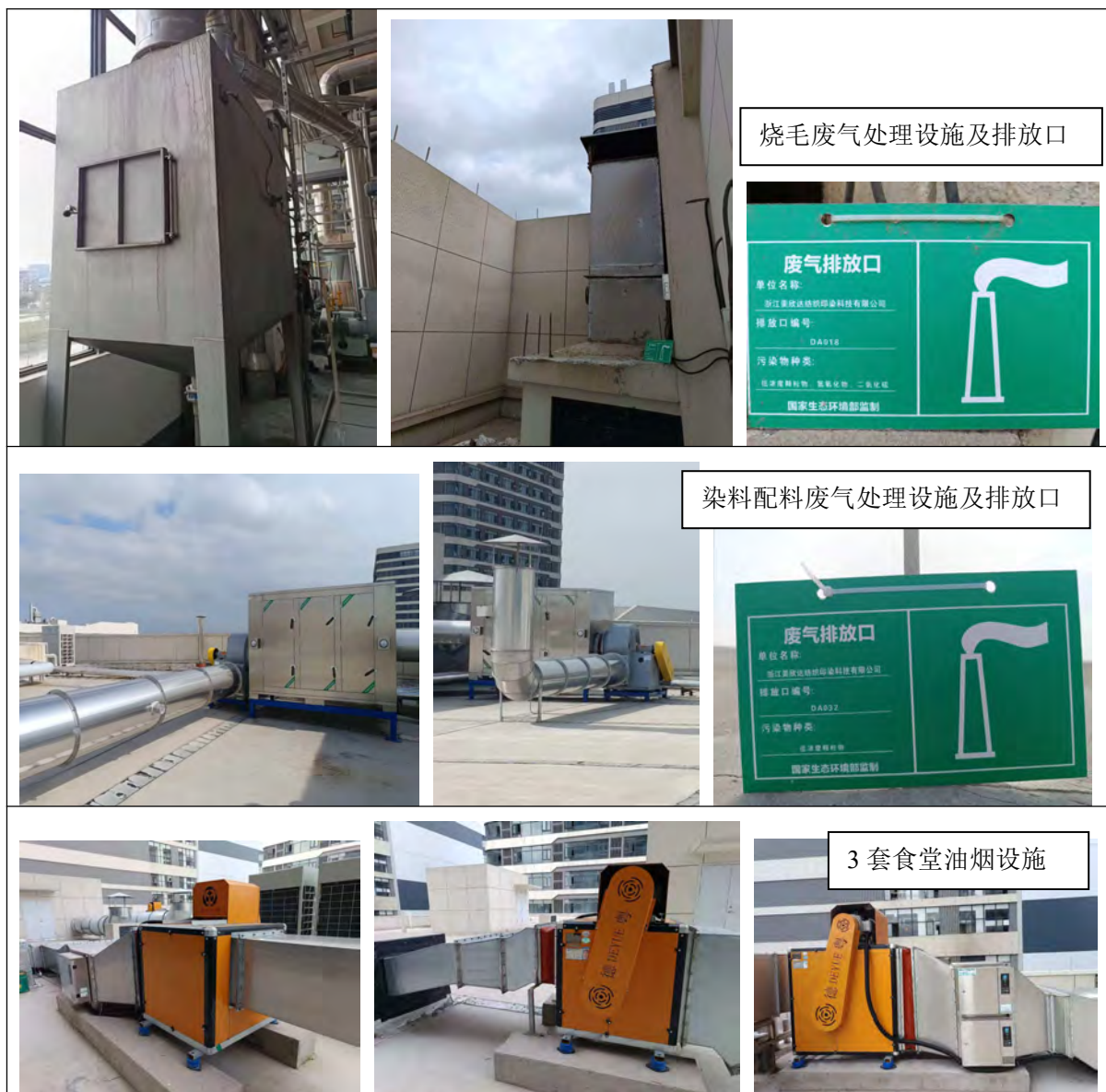
图 4-3 废气有组织处理设施现场
