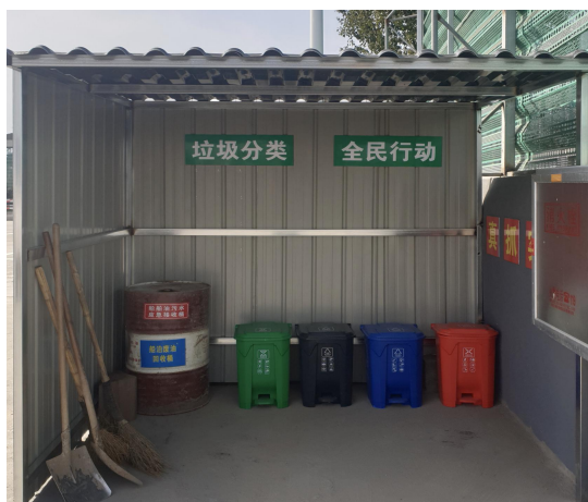
4.1-3 固废收集措施照片
