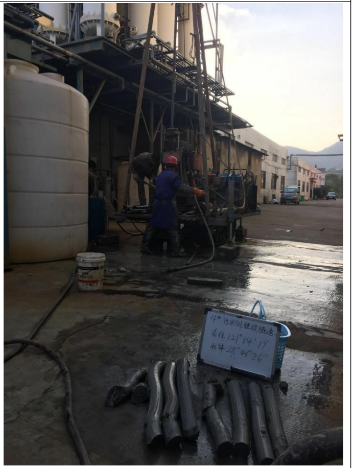
污水处理设施旁 4#
