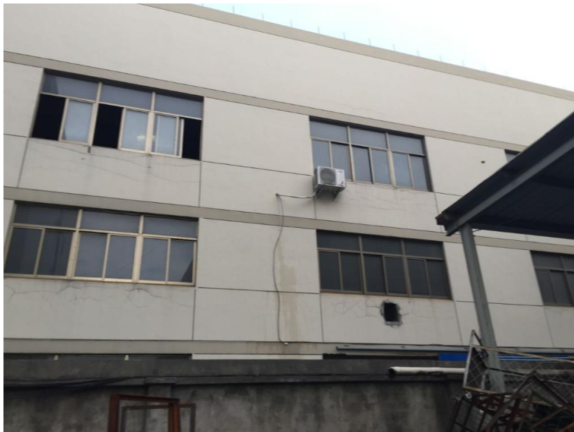
东侧 浙江丰华实业有限公司
