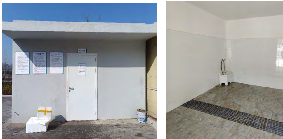
图 4-6 生活垃圾房现场照片
