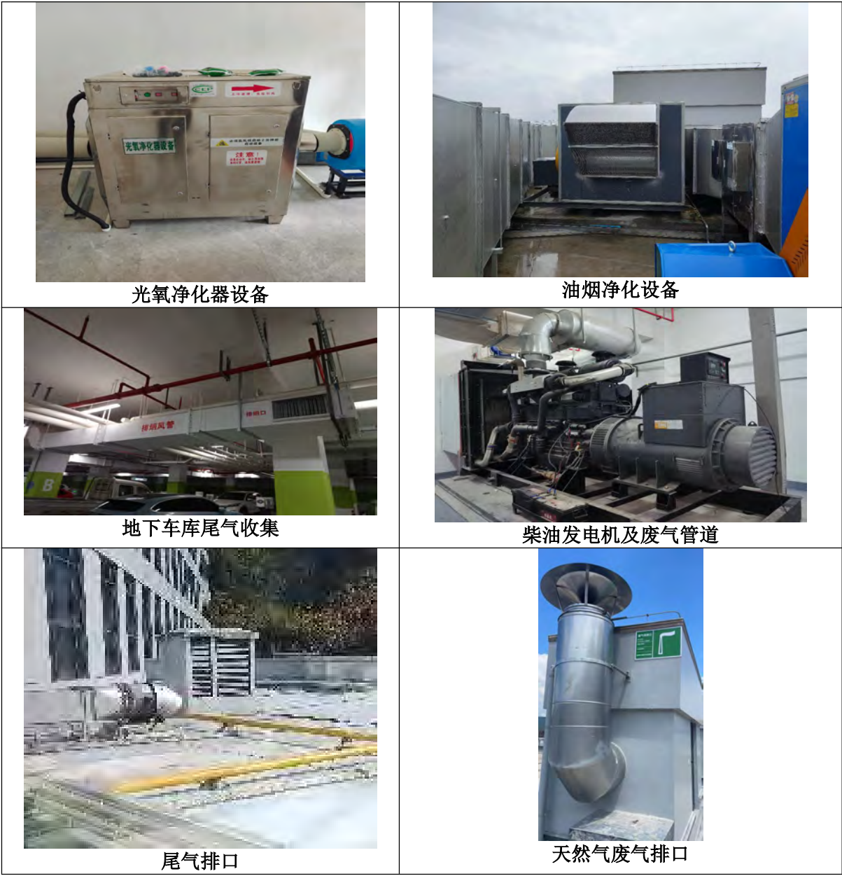
图 4-3 废气处理设施现场
