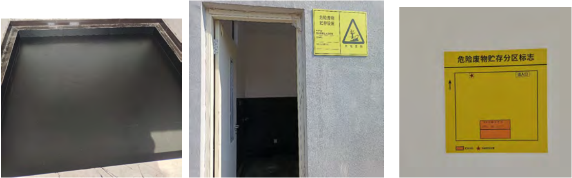
图 4-4 污泥暂存间现场照片
