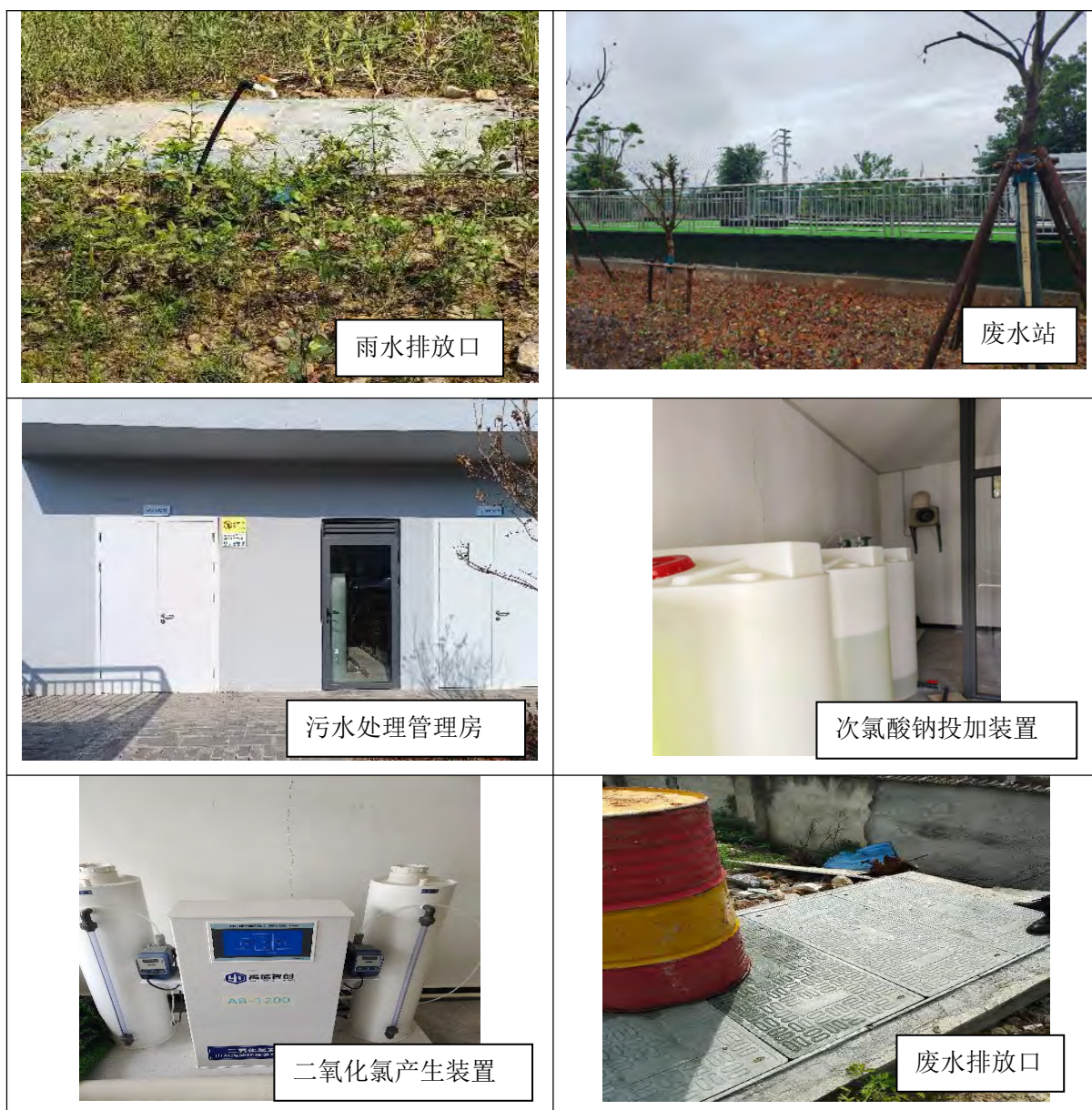
图 4-2 污水处理设施及污水总排放口
