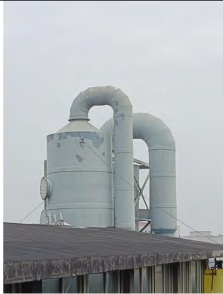
酸溶废气收集处理
