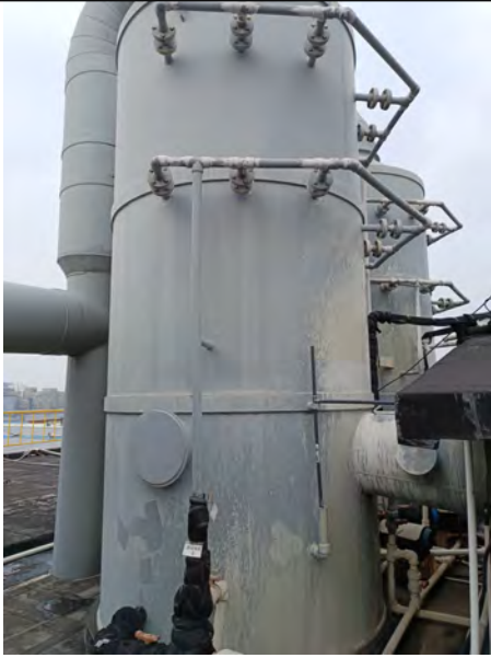
酸溶废气收集处理
