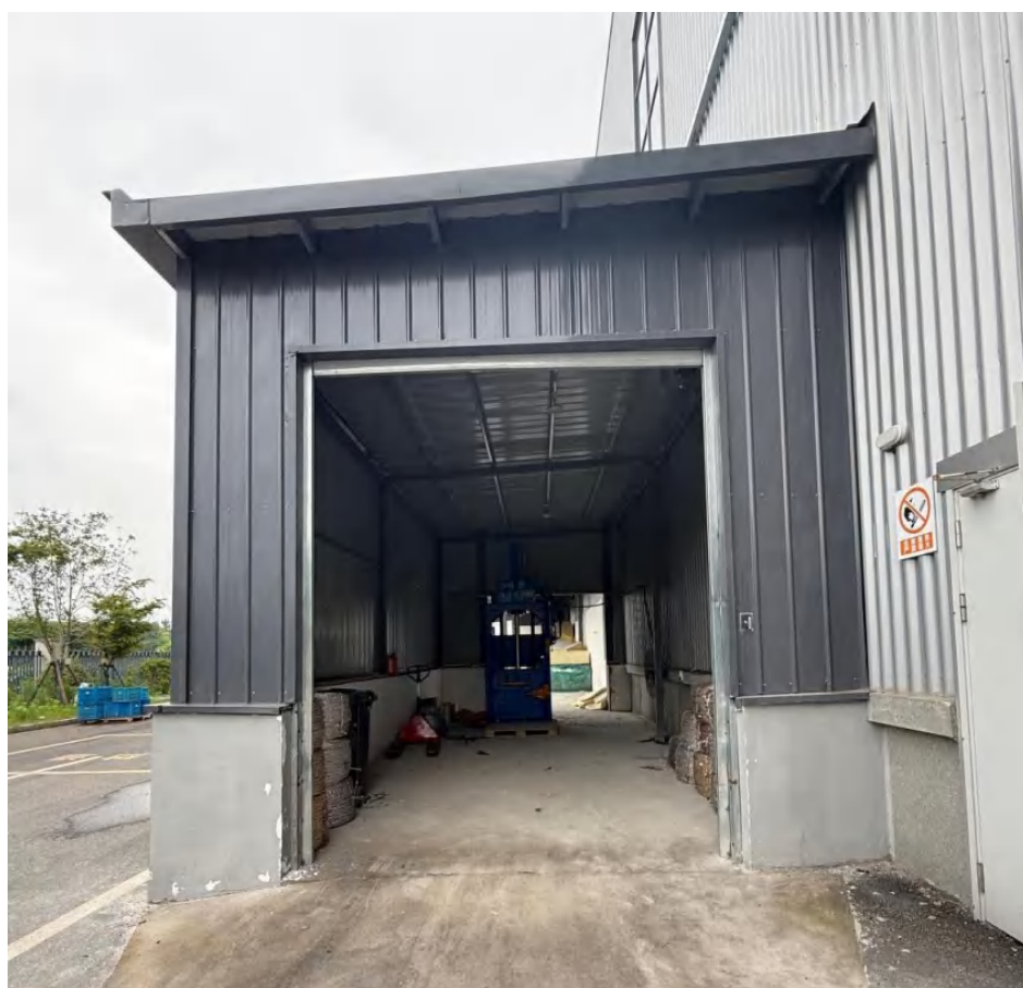
图3.4-2 工业固废暂存间照片
