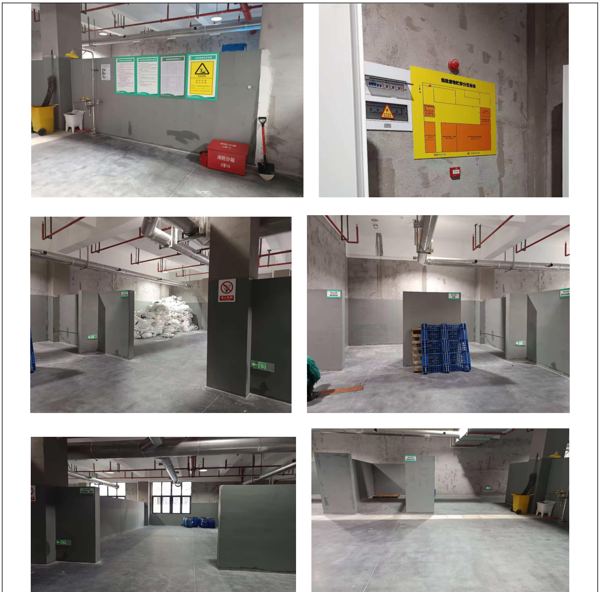
图 4-6 危险废物暂存库现场照片
