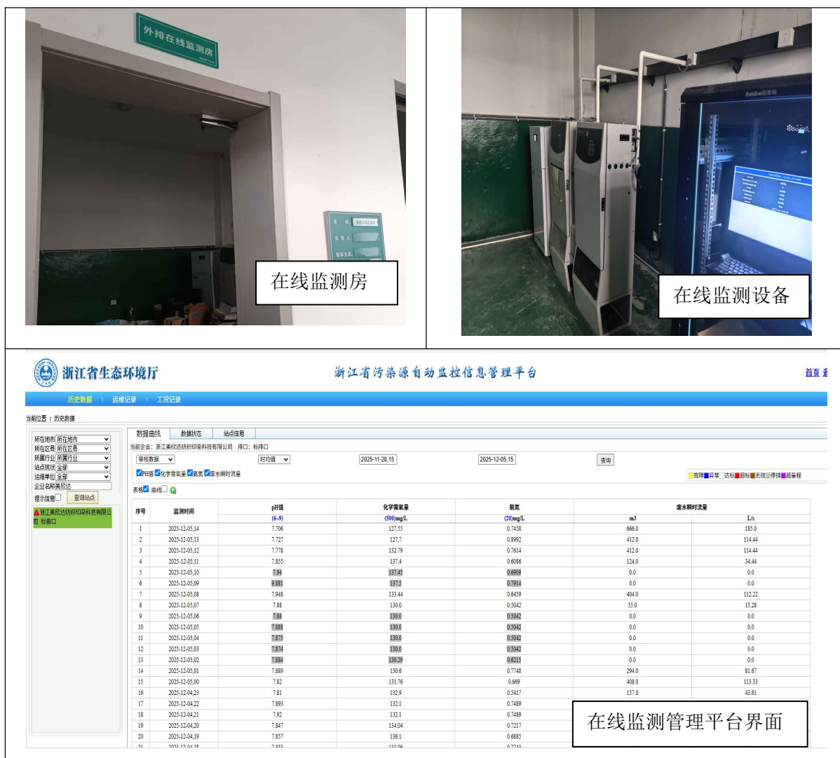
图 4-8 废水在线监测建设情况
