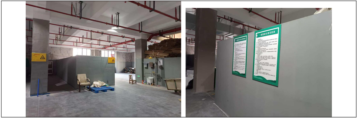
图 4-5 污泥堆放间、白泥堆放间、一般固废库现场照片
