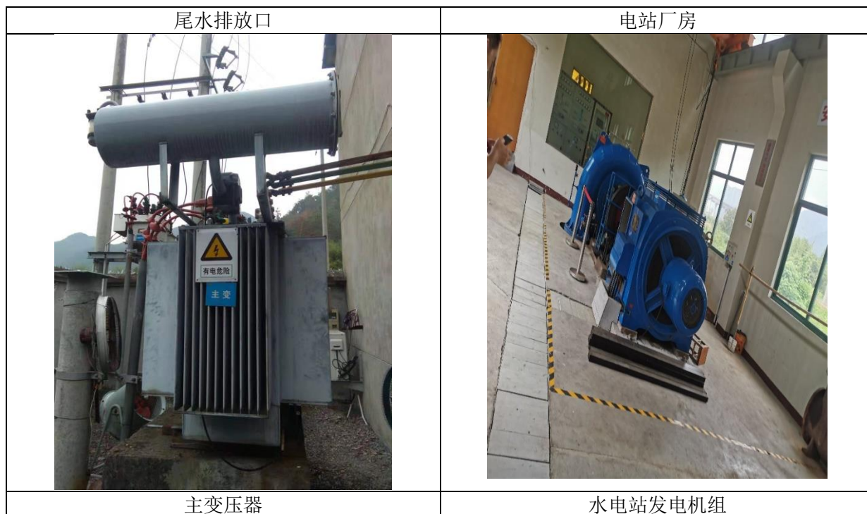
图 3.2-3 水电站构筑物
