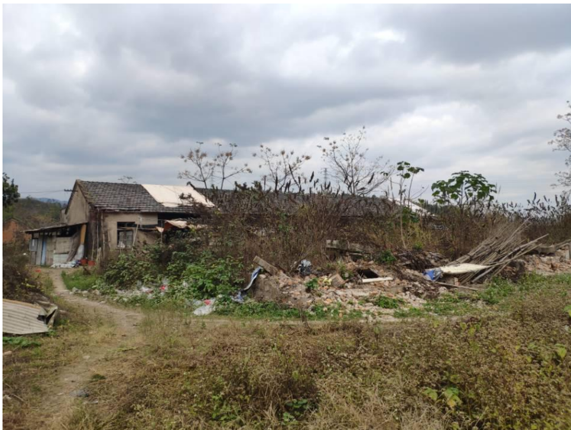
地块内东北侧建筑情况
