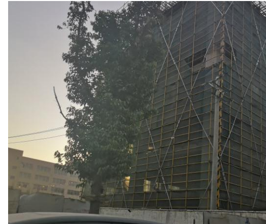
西北侧：施工厂房
