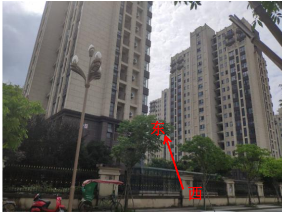
项目东侧（德馨家园）
